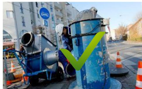
Exemple d'installation d'un système de ventilation avant intervention dans les réseaux d'assainissement (source INRS)
